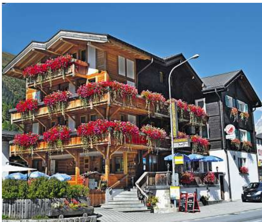
L'hôtel Grimsel à Obergesteln a été agrandi et modernisé peu à peu.
