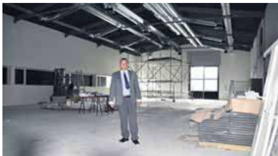
Reto Wüthrich lors de la transformation de la nouvelle salle.
