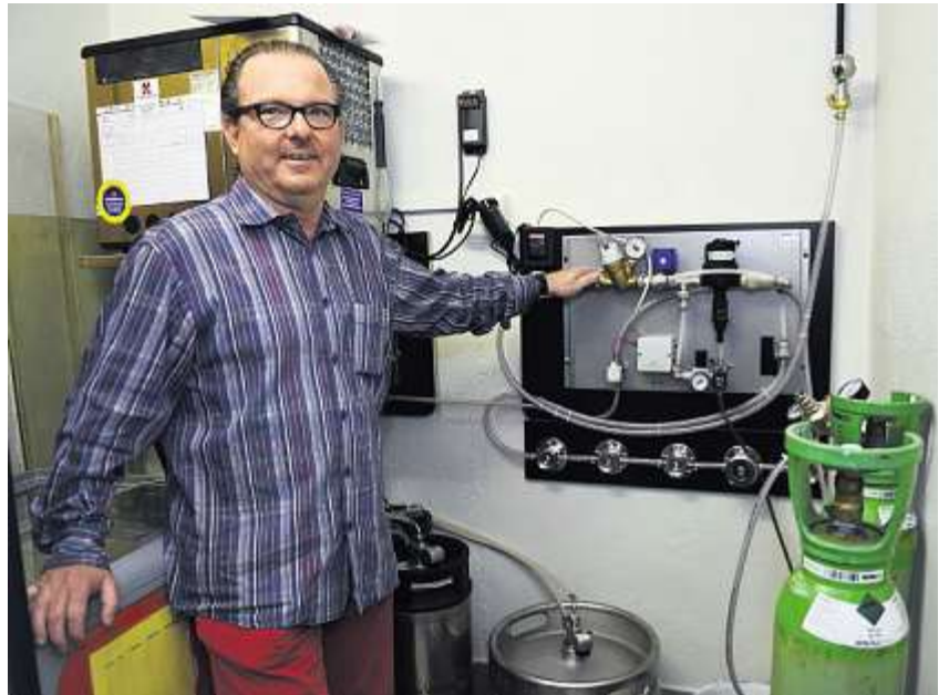
Avec l'installation autonettoyante, le restaurateur Bruno Cogliati ...
